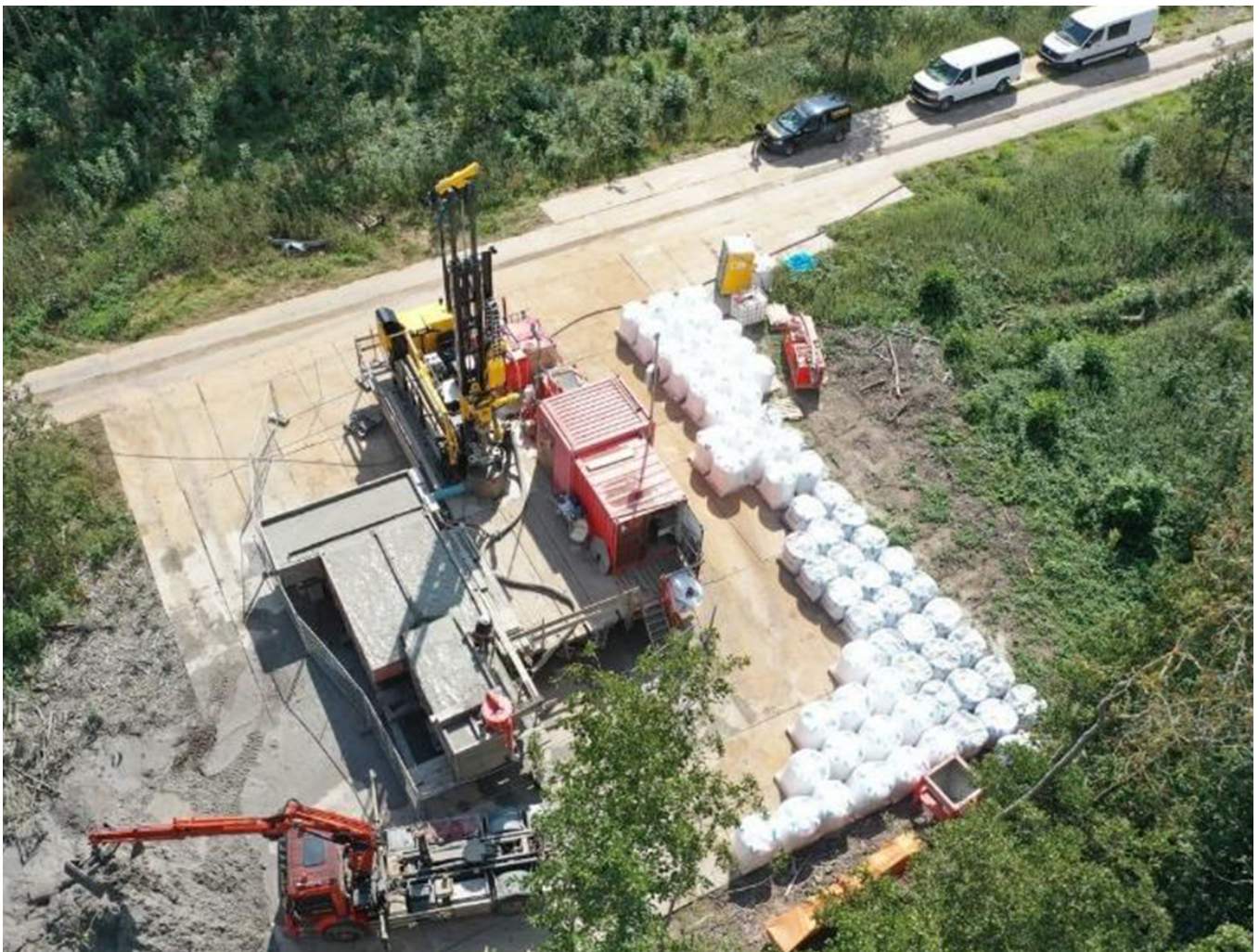
Figuur 5-4: Voorbeeld opstelling voor het boren van een winput
